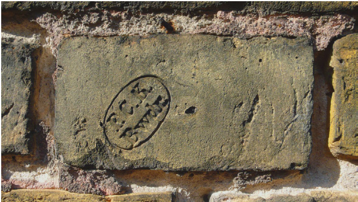
1. Garde-Drögoner-Regiment: Ziegelstempel der Ziegelei Friedrich Carl Krause Birkenwerder (F.C.K Bwdr.) Verblendmauerwerk an den Resten der Pferdeställe. Der Mörtel zur Fugung ist mit rotem Bolus hellrötlich angetönt.
