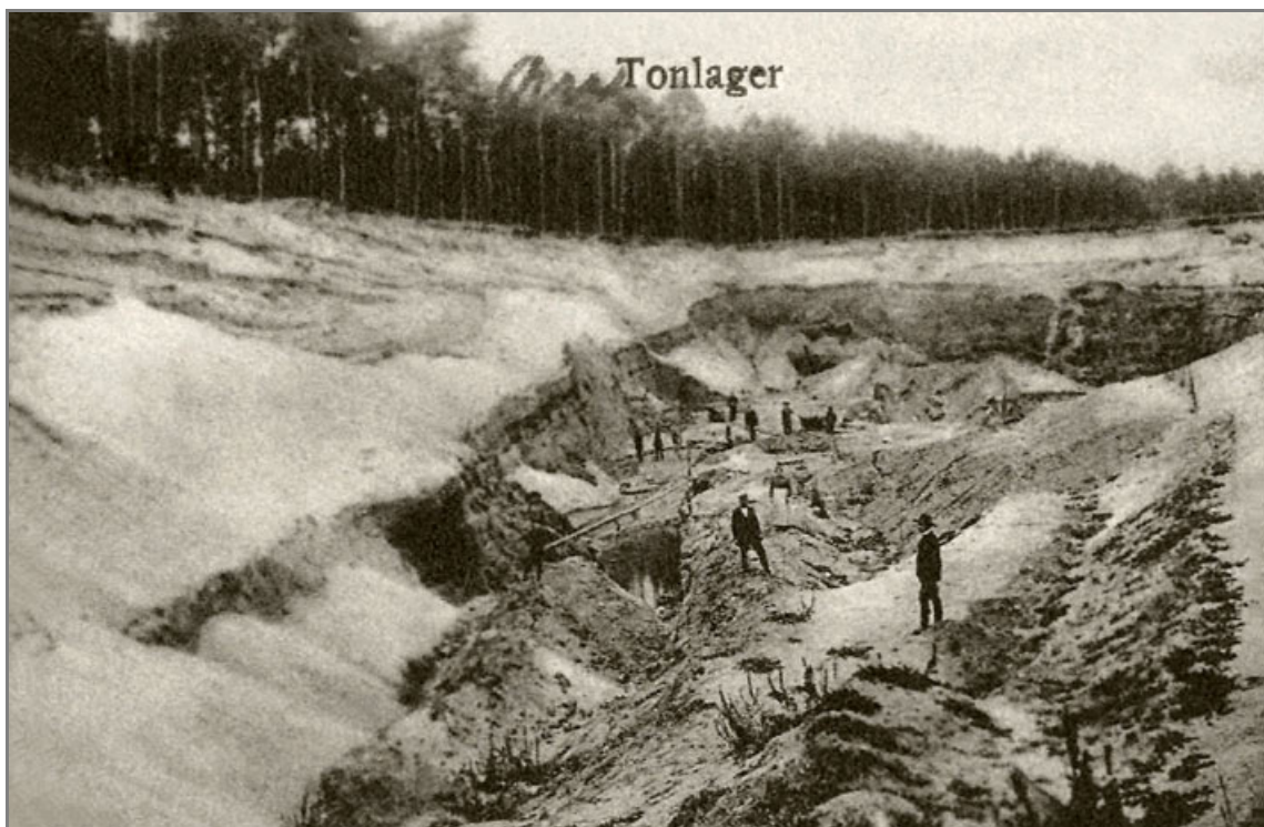
Schwerin a. Warthe: Hennig'sche Ziegeleien; Tonlager.
